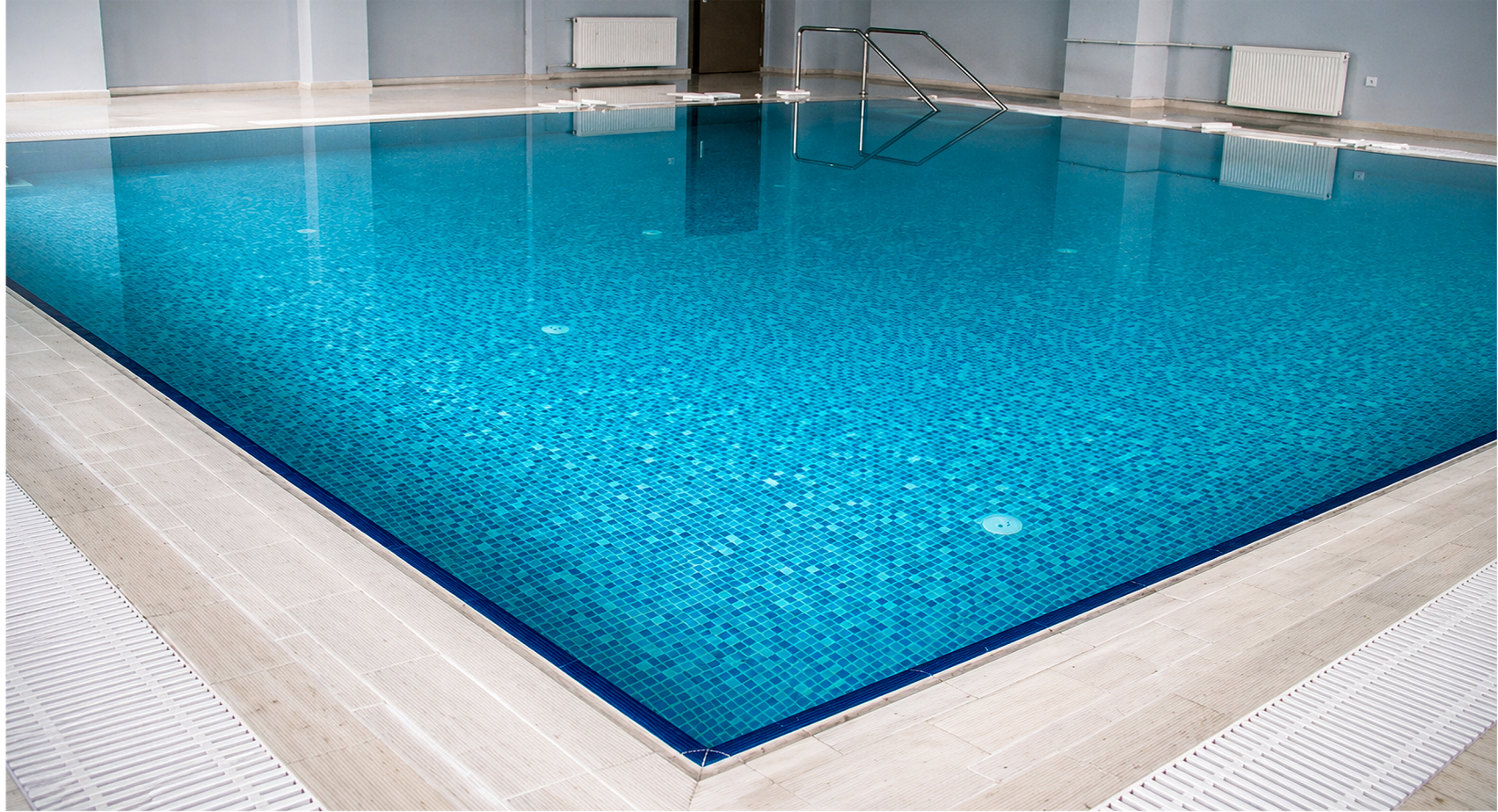
Kapalı Yüzme Havuzu Aşgabat, Türkmenistan
