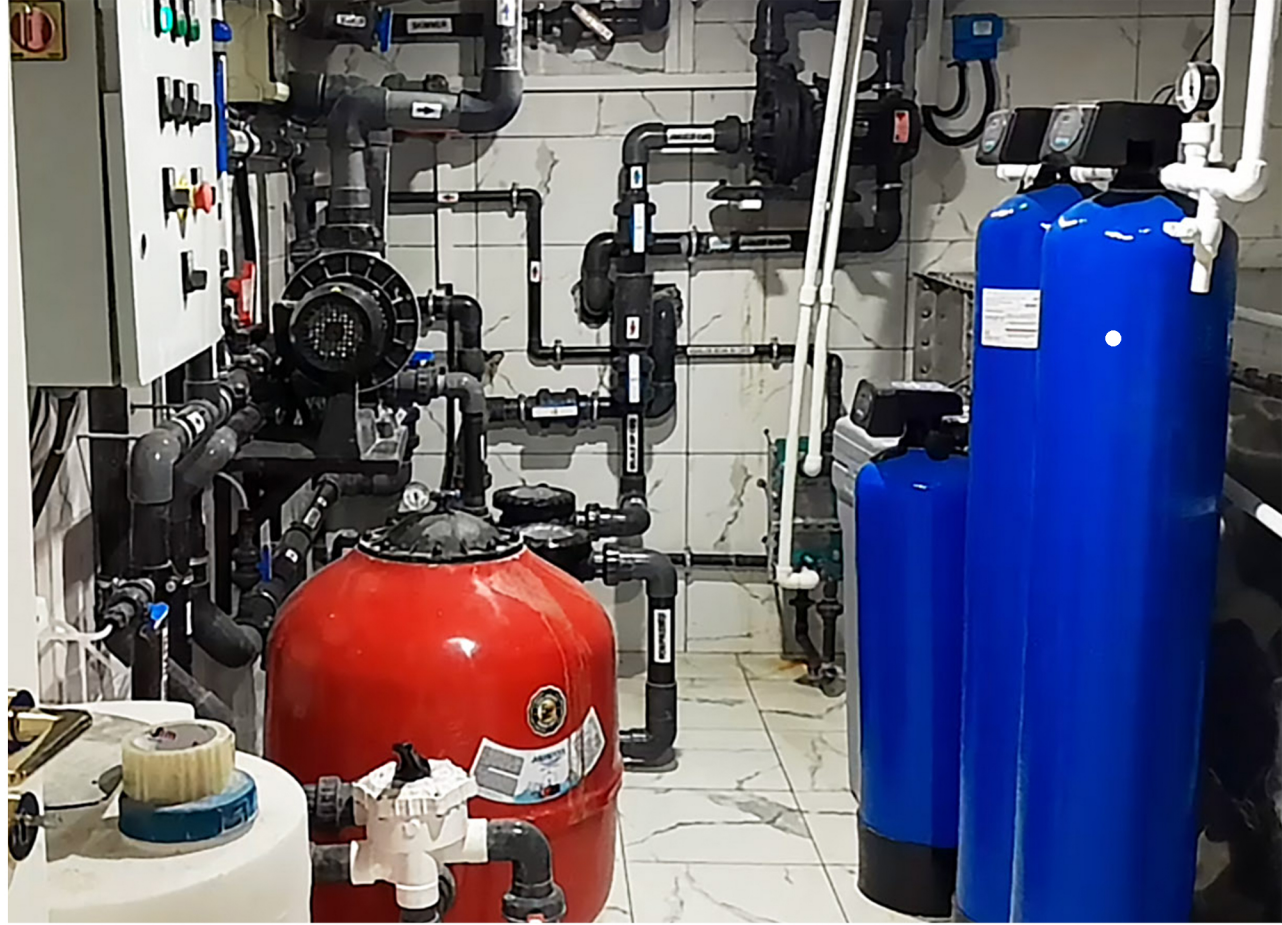
Sn.Nabi Rouis Kapalı Yüzme Havuzu mekanik, Filtrasyon ve Dezenfeksiyon Sistemi, İstanbul, Türkiye
